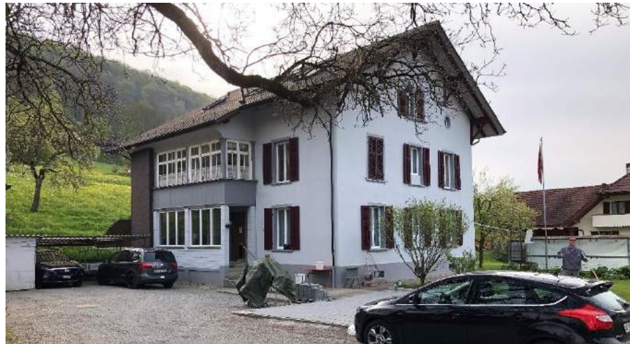
Abbildung 31: Beispiel einer im Gebäudevolumen integrierten Laubenschicht (Hauptstrasse 26, eigene Aufnahme)
