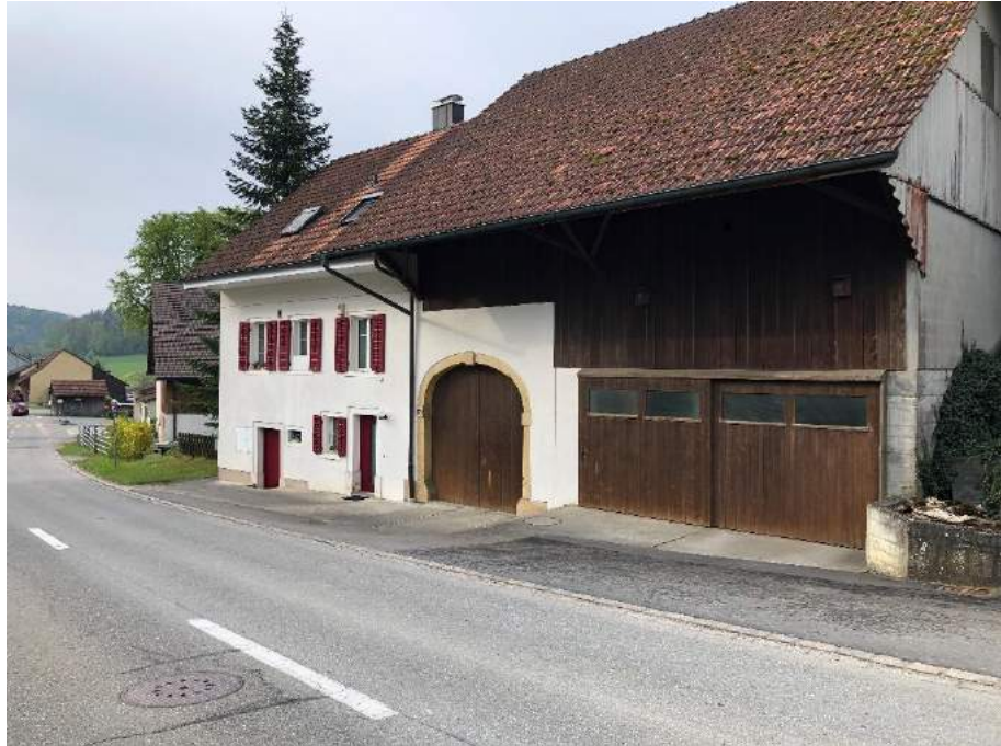
Abbildung 27: Bäuerlicher Vielzweckbau mit Nutzungsreserven im Ökonomieteil (Hauptstrasse 25, eigene Aufnahme)
