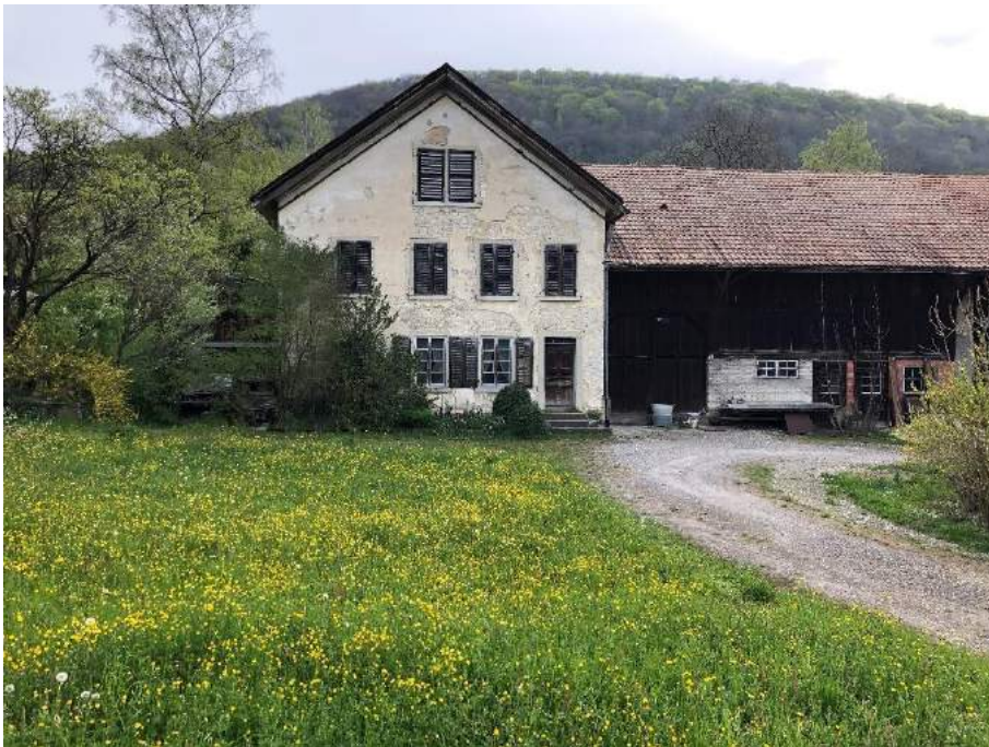
Abbildung 26: Bäuerlicher Vielzweckbau mit grossen Nutzungsreserven im Ökonomieteil (Hauptstrasse 95, eigene Aufnahme)
