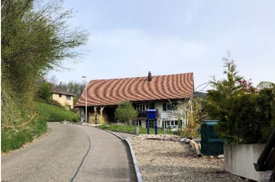
Abbildung 29: Originale Dachfläche mit typischen Auskragungen im Wohn- und Ökonomie teil, sensibel mit Dachaufbauten ergänzbar (Oberdorfstrasse 37, eig. Aufnahme)
