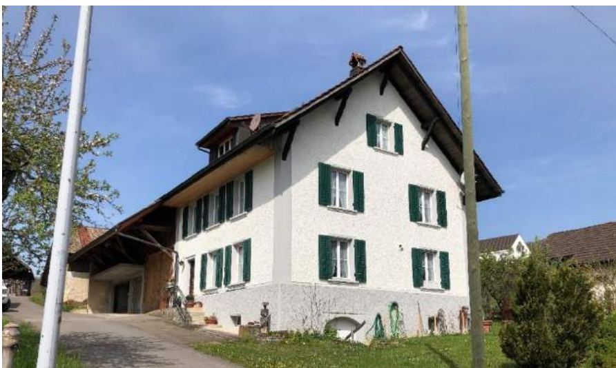
Abbildung 30: Symmetrische vertikale Befensterung mit Klappläden, Gebäudesockel (eigene Aufnahme)
