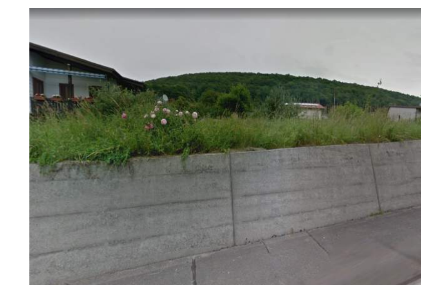
1a Ortschaftsgr., Stützmauer, Sichtachse 1
