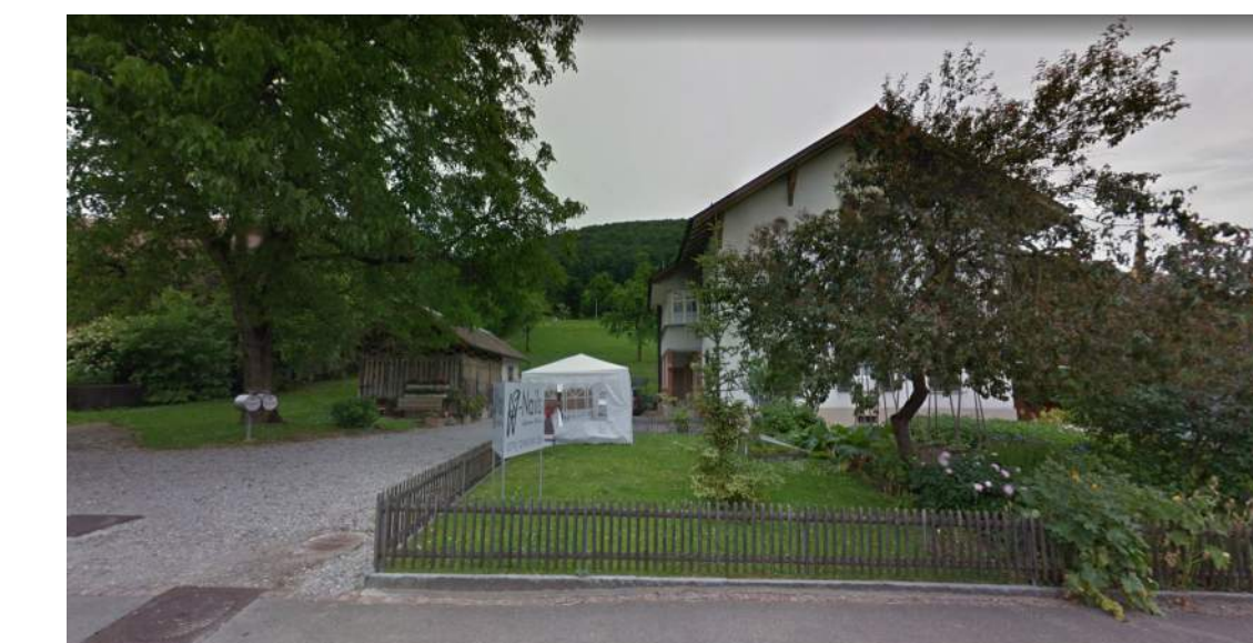
3 Sichtachse 3, Grunkorridor am Heng Richtung Burghalde, Ortsbildprägende Bauten mit historischem Wert, Erhalt Heberbaute erstrebenswert
